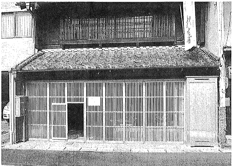
旧松喜仏壇店 町屋の特長である格子、引き戸、瓦屋根、漆喰壁などを回収することで本来町屋が持つ美しさを引き立たせます。町屋等の歴史的建造物の維持・復元工事に活用されたファンドの一例です。
